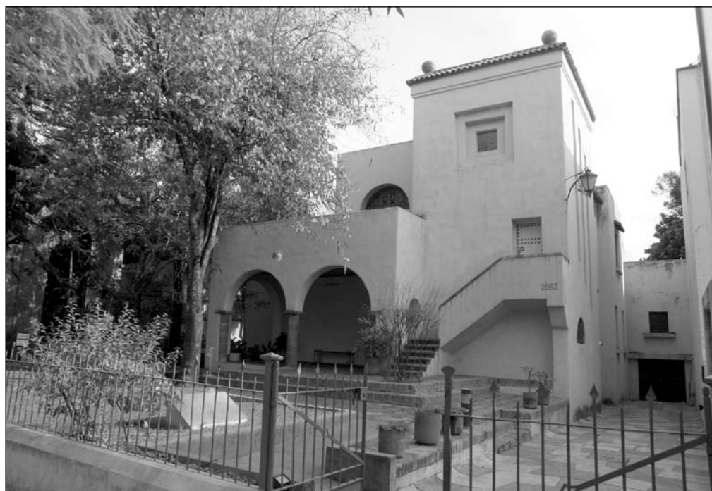
▲ Casa ITESO Clavigero, (construida por Luis Barragán entre 1929 y 1930) sobre la calle José Guadalupe Zuno. Foto: Abel Hernández
