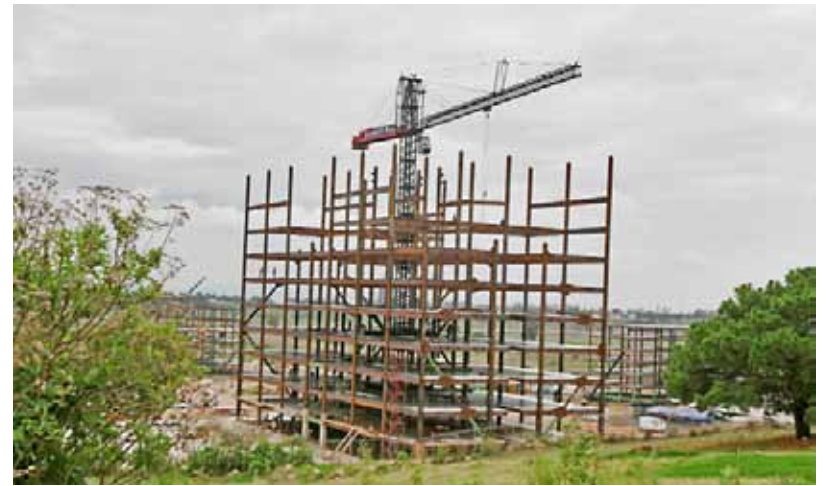
► Construcción de la Villa Panamericana, en el Bajío, Zapopan. Foto: Abel Hernández
