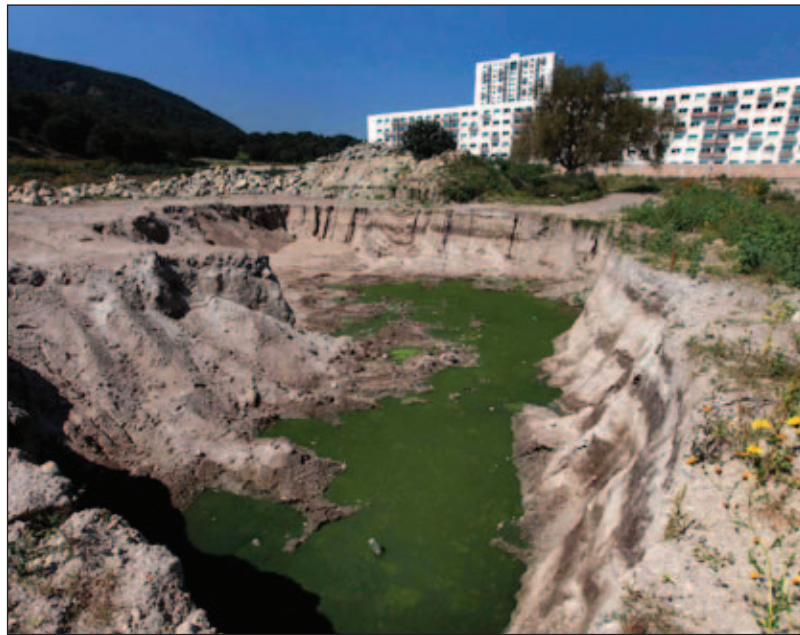
◀ Lagunas construidas a cielo abierto para contener desechos líquidos de las Villas Panamericanas. Foto: Archivo
